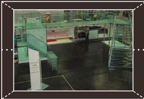
Aufbau der Treppenanlage
